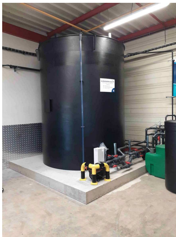
nouvelle cuve de stockage d'eau osmosée
